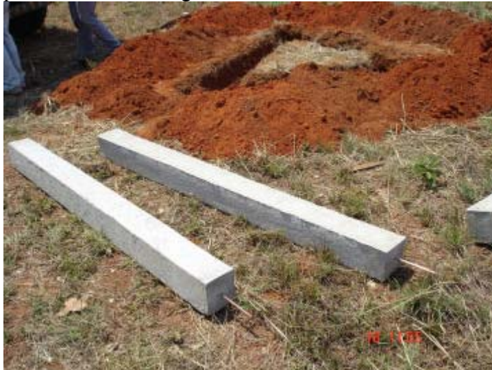
Figura 3 – Malha de Aterramento com Hastes Concretadas.
