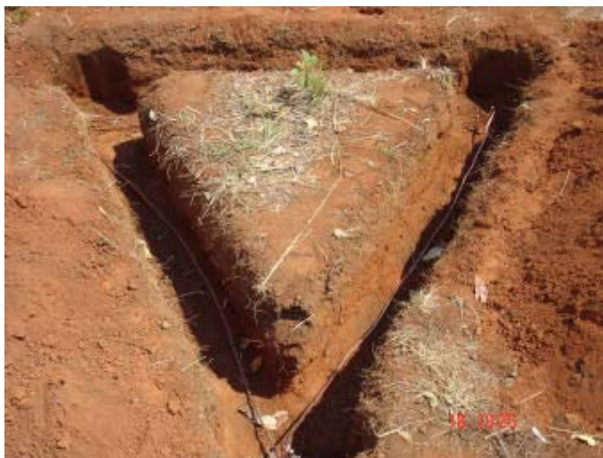
Figura 1 – Malha de Aterramento Tradicional.
